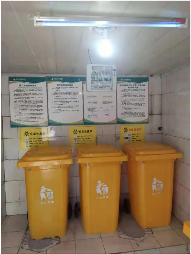
危废暂存间内部
